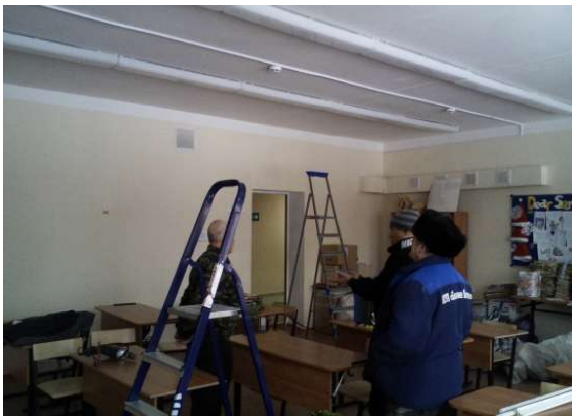
Монтажом проектора занимались профессионалы. Протягивали электрический кабель по потолку
