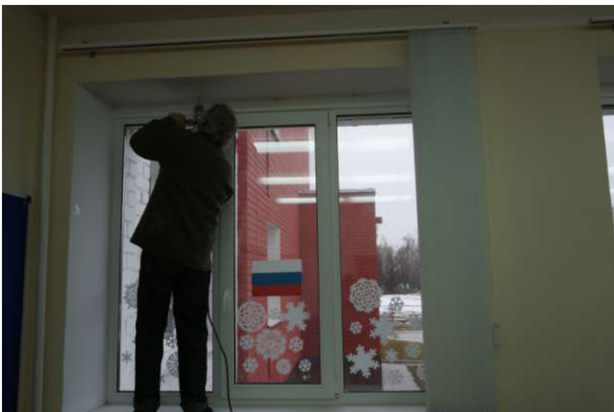
Монтаж потолочных карнизов для штор
